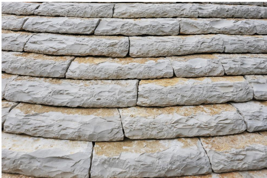
Toiture en lauze avec un pureau décroissant
