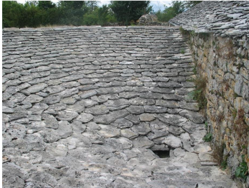
Toit-citerne couvert de lauses calcaires au Larzac, sud Aveyron, Massif central
