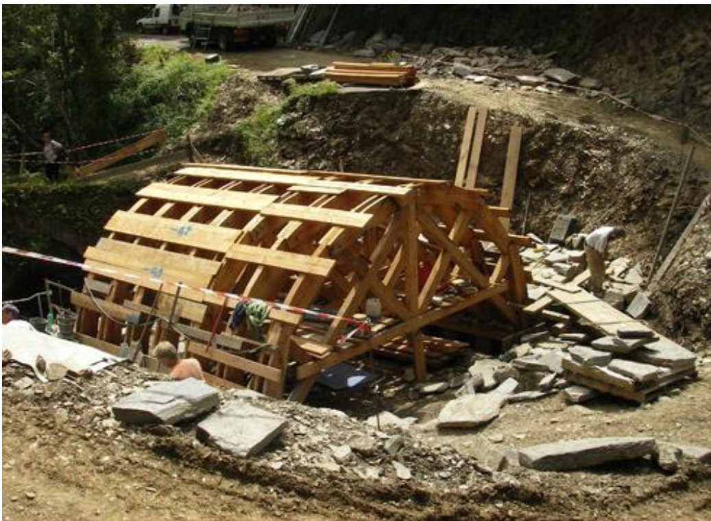
Photo du coffrage du Pont Chaldecoste Par Thomas Brasseur (source ABPS)
