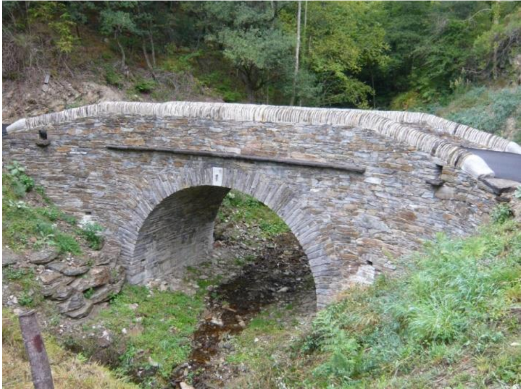
Photo du Pont Chaldecoste Par Thomas Brasseur (source ABPS)
